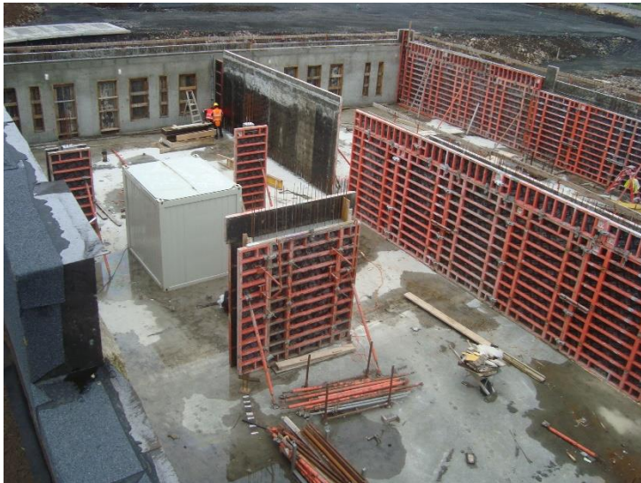
Hús D, unnið við steypu veggja á 1.h.
