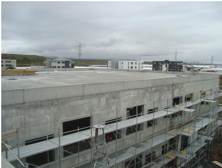
Hús A, uppsteipt.
