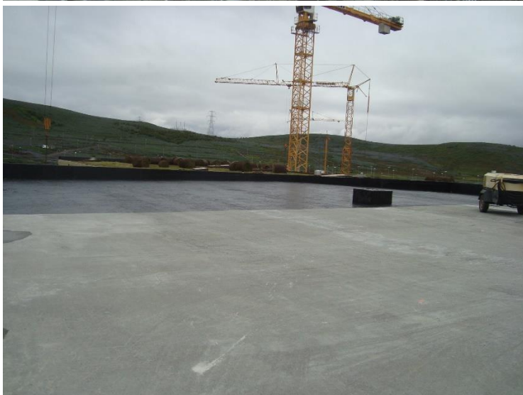
Hús B, uppsteipt, byrjað að grunna þak.
