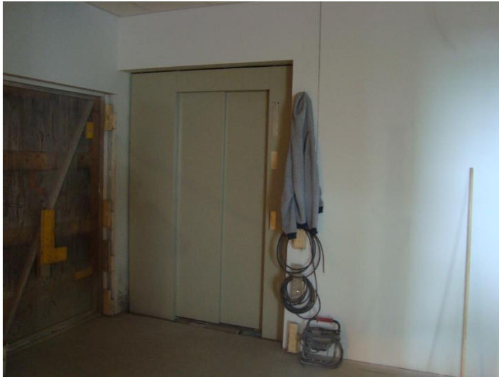
Hús C lyfta komin upp.
